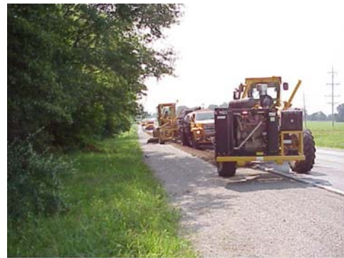
(2) Edge Rut Repair Train
